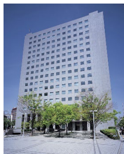
外壁補修工事の実施 (阪急電鉄本社ビル)
