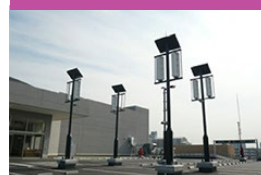
風車とソーラーパネルのハイブリッド型発電設備の設置
