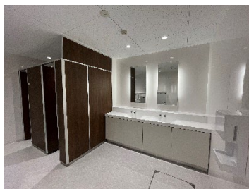
トイレリニューアル工事の実施 (メッツ大曽根)
