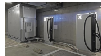
EV充電ステーションの設置
