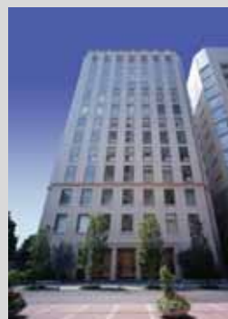
淀屋橋フレックス タワー
