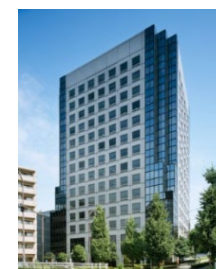
大崎MTビル
