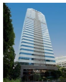
紀尾井町ビル
