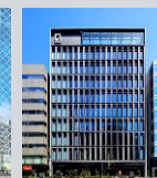
S-GATE 大手町北
