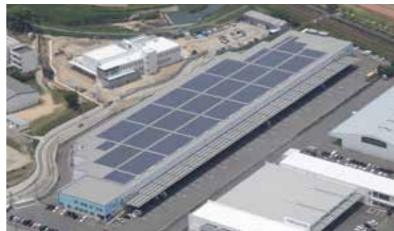
IIF鳥栖ロジスティクスセンター
