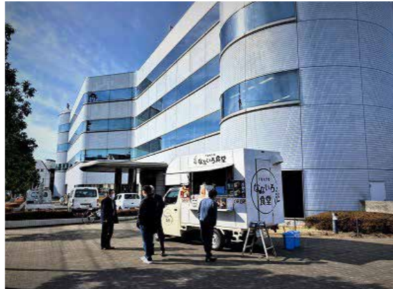
IIF品川データセンター
