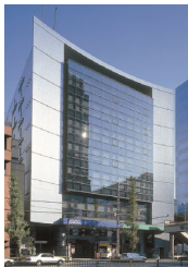
A-25 JREコスモ金杉橋ビル
