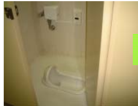
高輪一丁目ビル 改装前 トイレ
