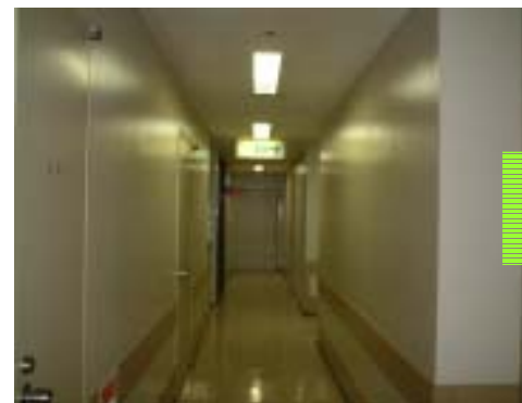
札幌南二条ビル廊下リニューアル前
