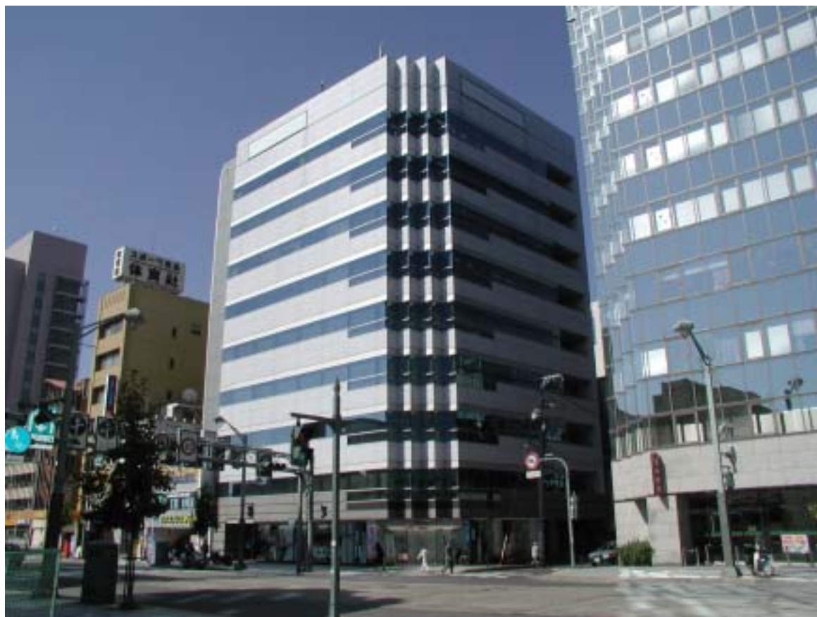
S K 広島ビル外観写真
