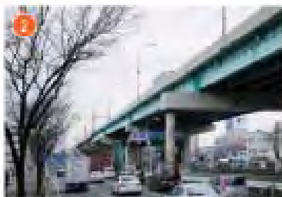
福岡都市高速・樋田入口
