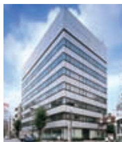
Ⅲ-7 NAGOYA MISONO BUILDING 名古屋御園ビル
