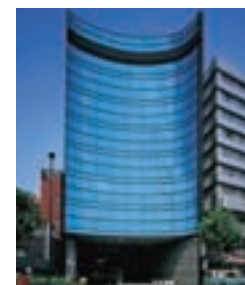
I-28 IKEBUKURO YS BUILDING 池袋YSビル
