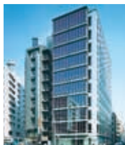
I-2 MD KANDA BUILDING MD神田ビル
