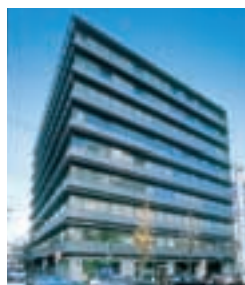
Ⅲ-8 KYOTO SHUO KAWARAMACHI BUILDING 京都四条河原町ビル
