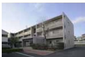
【太平洋セメント東久留米寮新館】
