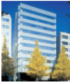
Ⅲ-3 SENDAI HONCHO HONMA BUILDING 仙台本町ホンマビルディング
