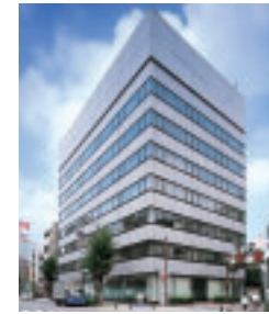
Ⅲ-8 NAGOYA MISONO BUILDING 名古屋御園ビル
