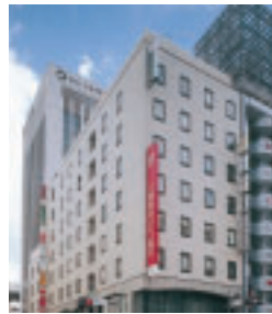
I-12 GINZA SANWA BUILDING 銀座三和ビル
