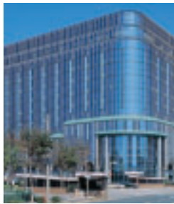
Ⅲ-4 KANAZAWA PARK BUILDING 金沢パークビル
