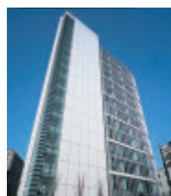
I-25 YOYOGI 1CHOME BUILDING 代々木1丁目ビル
