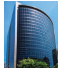
Ⅲ-10 SHIN-FUJITA BUILDING 新藤田ビル
