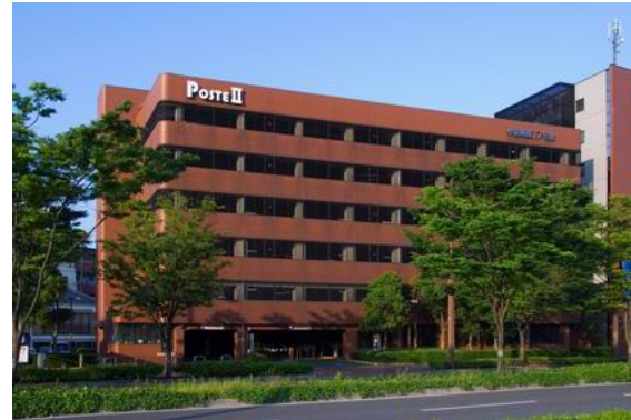
B12: 小倉興産17号館 (駐車場)
