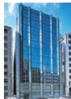
53 NBF広島立町ビル
