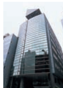
20 住友電設ビル
