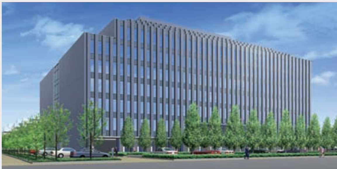
A (仮称) 豊洲5丁目ビル 東京周辺都市部 取得予定時期 平成20年3月
