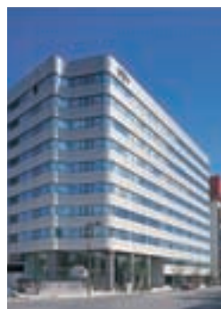
42 NBFユニックスビル
