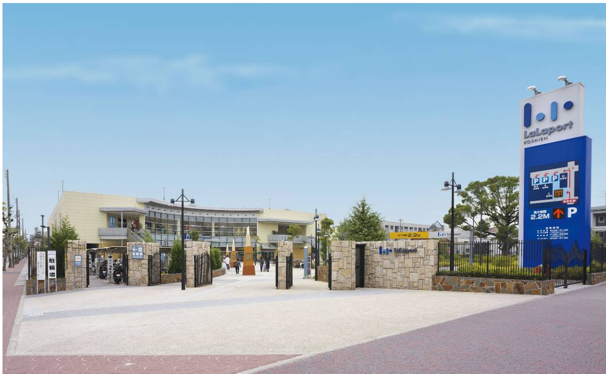
<ららぽーと甲子園（敷地）外観写真>
