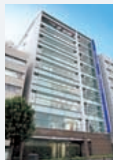
赤坂四丁目ビル （東急エージェンシー本社ビル）
