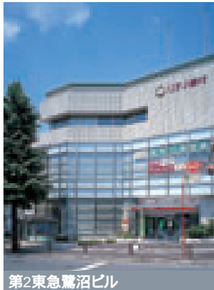
第2東急鷺沼ビル
