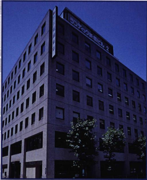
A2 ランディック第2新橋ビル
