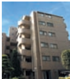
A14 アビタシオンクレール (大田区)
