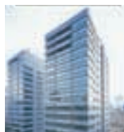
⑧ 興和西新橋ビルB棟
