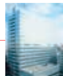
横浜STビル
