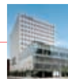
札幌エルプラザ
