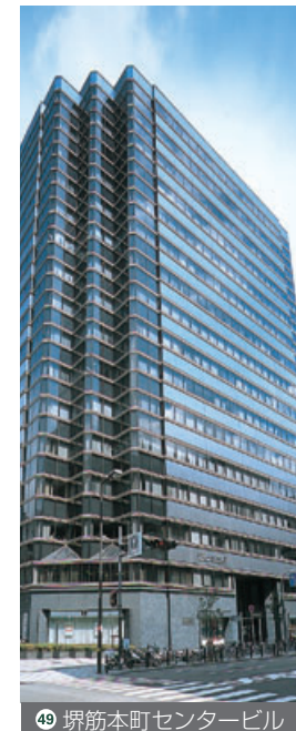
49 堺筋本町センタービル
