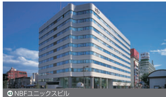
43 NBFユニックスビル
