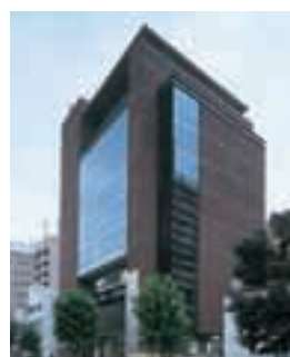
I-18 JINGUMAE MEDIA SQUARE BUILDING 神宮前メディアスクエアビル
