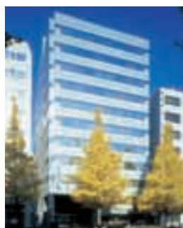
III-1 SENDAI HONCHO HONMA BUILDING 仙台本町ホンマビルディング
