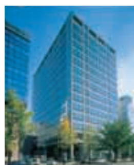
III-9 MIDOSUJI DAIWA BUILDING 御堂筋ダイワビル
