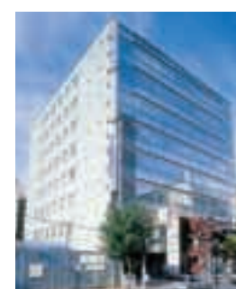
II-1 SAITAMA URAWA BUILDING さいたま浦和ビルディング
