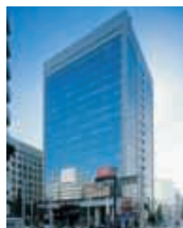
III-5 NAGOYA HIROKOJI BUILDING 名古屋広小路ビルディング
