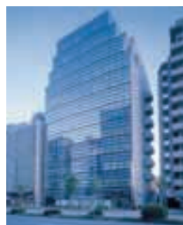
I-12 TAKANAWADAI BUILDING 高輪台ビルディング
