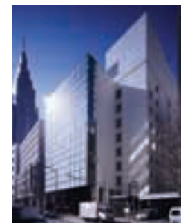
I-15 NIPPON BRUNSWICK BUILDING 日本ブランズウィックビル
