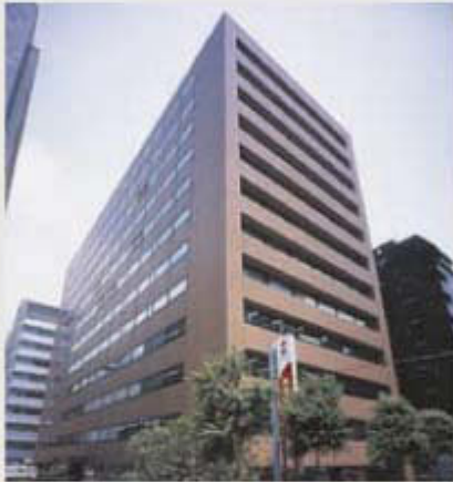
⑦ NBF日本橋室町センタービル
