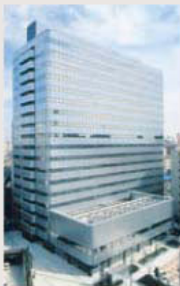
29 横浜STビル
