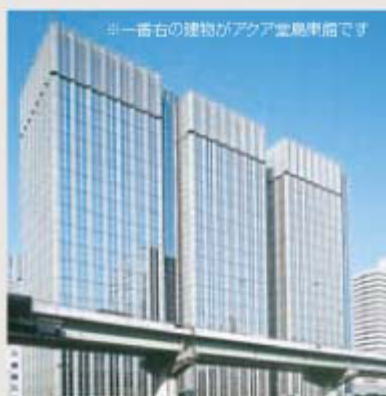
⑫ アクア堂島NBFタワー・東館
