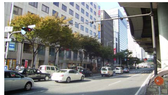
〈難波阪神ビルの面する千日前通〉
