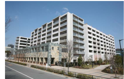
大和ハウスの賃貸住宅の建築事例
