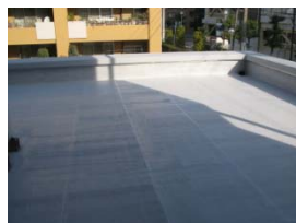
エントランス上部防水工事
