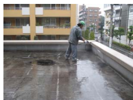
エントランス上部防水工事
