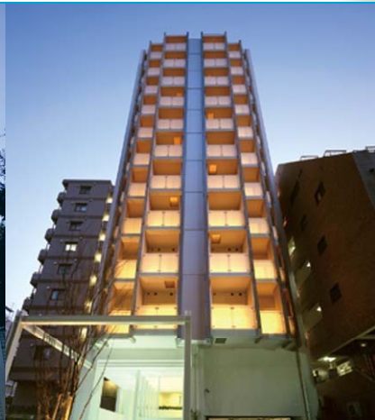
J-18 イプセ麻布十番DUO 住所: 東京都港区麻布十番二丁目21番2号 アクセス: 南北線麻布十番駅から徒歩1分 階数: 14階建て 建築時期: 平成18年3月8日 賃貸可能戸数: 66戸
