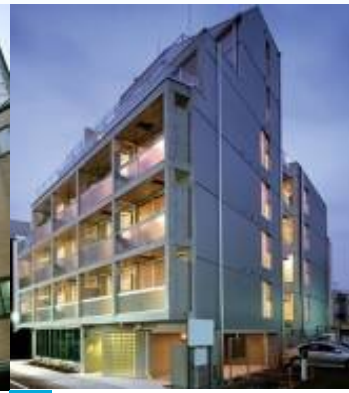
J-21 イプセ祐天寺 住所: 東京都目黒区祐天寺二丁目14番21号 アクセス: 東急東横線祐天寺駅から徒歩1分 階数: 7階建て 建築時期: 平成18年3月3日 賃貸可能戸数: 29戸(内店舗2戸)
