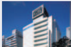
US-1 大阪心斎橋8953ビル
