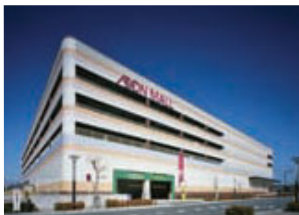
イオンモール東浦の駐車場棟新築
