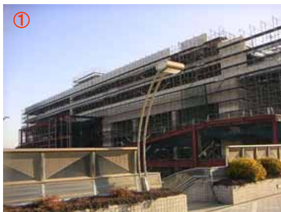
① 工事風景撮影(H18.2)
