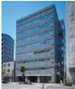
Of-15 大和中目黒ビル Daiwa Nakameguro Building
