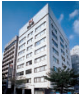
Of-10 日総第15ビル Nisso Dai 15 Building
