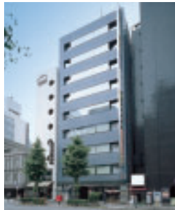
Of-14 KCAビル KCA Building
