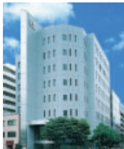
Of-06 NV富岡ビル NV Tomioka Building
