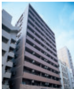
Re-17 エルミタージュ東神田 Hermitage Higashikanda
