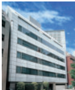
Of-08 国際溜池ビル Kokusai Tameike Building
