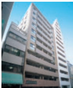
Re-18 エルミタージュ東日本橋 Hermitage Higashinohonbashi
