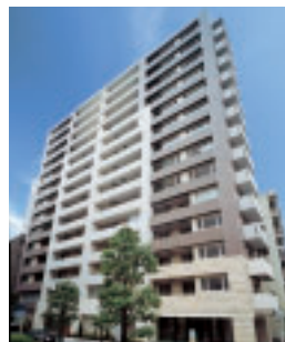
Re-20 ランドステージ白金高輪 Landstage Shirokanetakanawa
