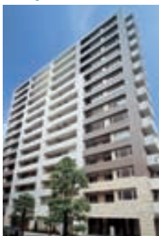
Re -20 ランドステージ白金高輪 Landstage Shirokanetakanawa
