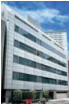
Of -08 国際溜池ビル Kokusai Tameike Building
