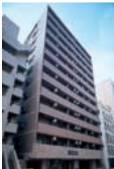
Re -17 エルミタージュ東神田 Hermitage Higashikanda
