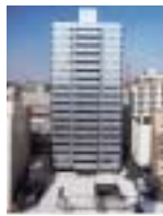
横浜 ST ビル
