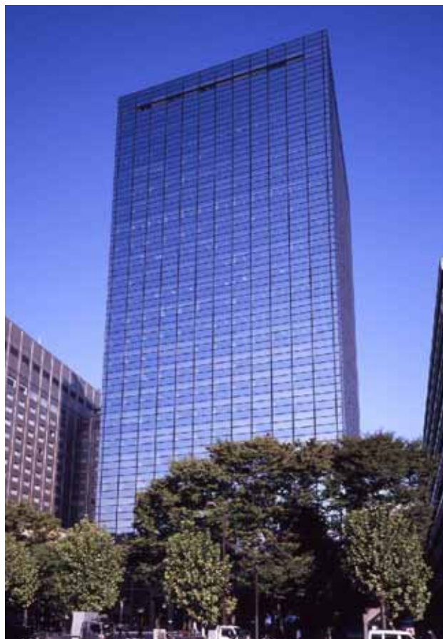
大和生命ビル全景
