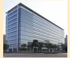
晴海センタービル
