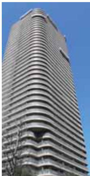
大川端賃貸棟の外壁等大規模改修工事
