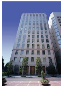
淀屋橋フレックス タワー
