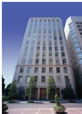
淀屋橋フレックス タワー
