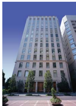
淀屋橋フレックス タワー
