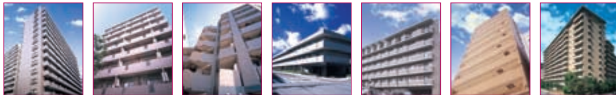
D1 T&G東池袋マンション D2 T&G四谷マンション D3 エクセリア馬込 D4 駒沢コート D5 六本松コート D6 スカイコート芝大門 D7 太平洋セメント社宅 (メゾン浮間)
