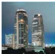
愛宕グリーンヒルズ (平成13年7月竣工)
