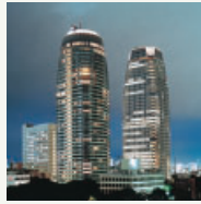
愛宕グリーンヒルズ (平成13年7月竣工)
