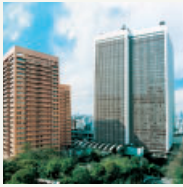
アークヒルズ (昭和61年3月竣工)
