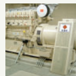
非常用発電システム
