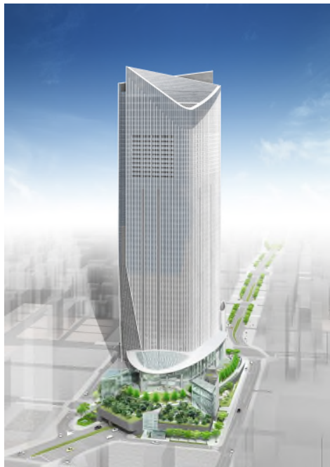
超高層棟全景 (注2)
