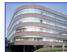
東急南平台町ビル
