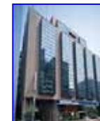
東京日産台東ビル
