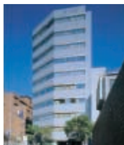
III-11 KOBE ITOMACHI BUILDING 神戸伊藤町ビルディング
