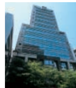
III-15 TENJIN CRYSTAL BUILDING 天神クリスタルビル
