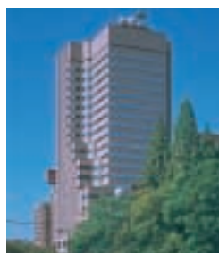
III-13 NHK HIROSHIMA BROADCASTING CENTER BUILDING NHK広島放送センタービル
