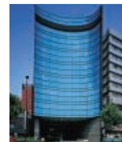
I-32 IKEBUKURO YS BUILDING 池袋YSビル
