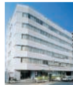
I-21 JAL SALES BUILDING JALセールスビル
