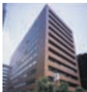
3 日本橋室町センタービル
