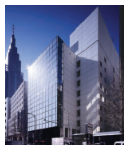
I-22 NIPPON BRUNSWICK BUILDING 日本プランズウィックビル
