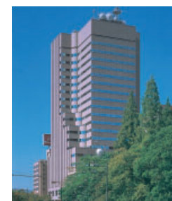
III-13 NHK HIROSHIMA BROADCASTING CENTER BUILDING NHK広島放送センタービル
