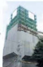
現場会議への参加等 による施工内容の確認
