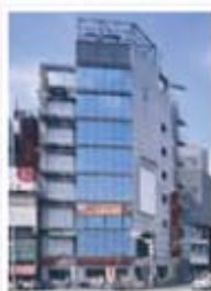
C2 代々木Mビル Yoyogi M Building
